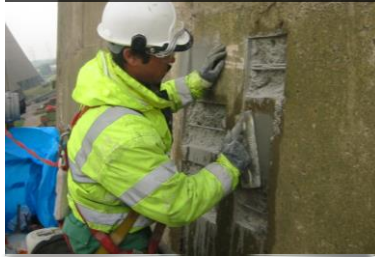
Reparación del hormigón
