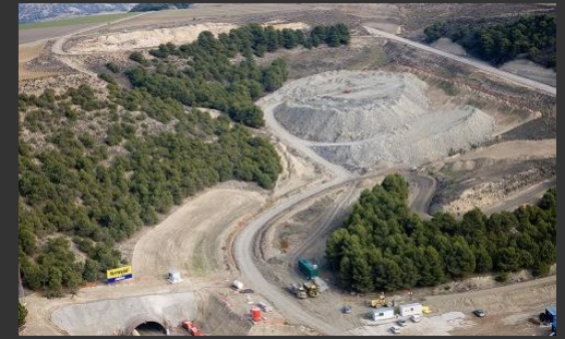
Túnel AVE Valladolid-Burgos (Cabezón de Pisuerga)
