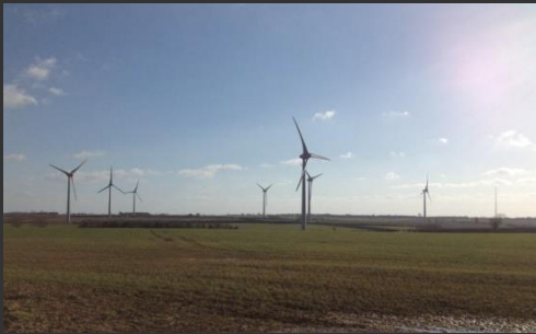
Parque eólico Burton Wold (Inglaterra)
