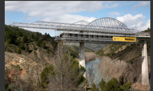
Viaducto de Cofrentes (Valencia)
